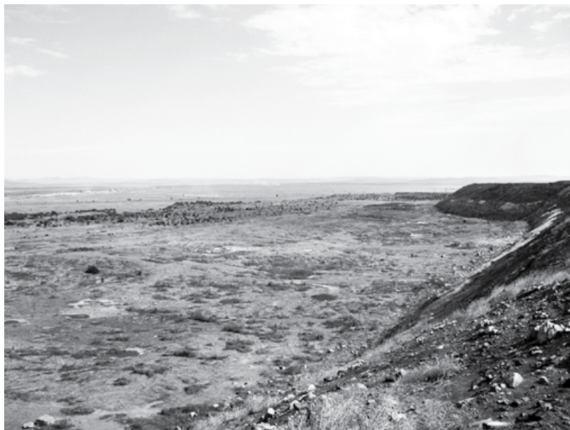
Рис. 2 Выположенный отвал 1994 г. Разрез «Черногорский» ООО «СУЭК Хакасия».
