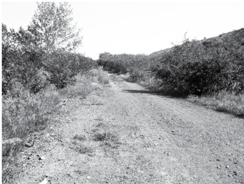
Рис. 1 Гребнистый отвал с технологической дорогой. Рекультивирован в 2007 г. Разрез «Черногорский» ООО «СУЭК Хакасия».
